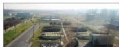
Oczyszczalnia Radocha II. Fot. RPWiK Sosnowiec S.A.
