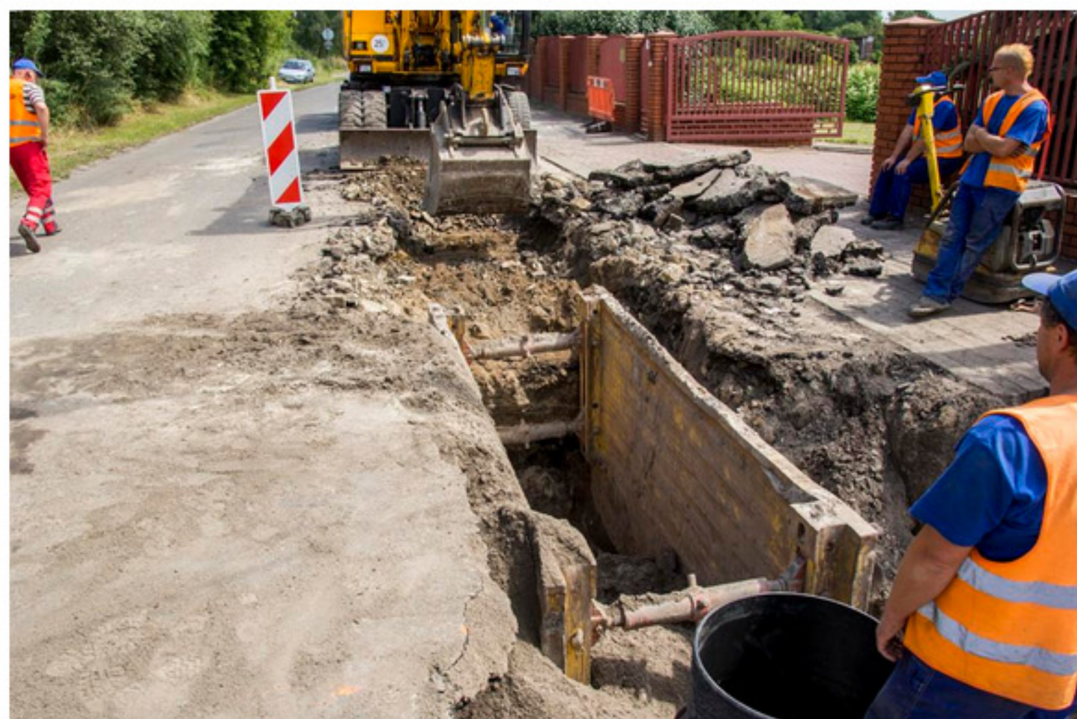
Przebudowa sieci w Klimontowie – fot. UM Sosnowiec
