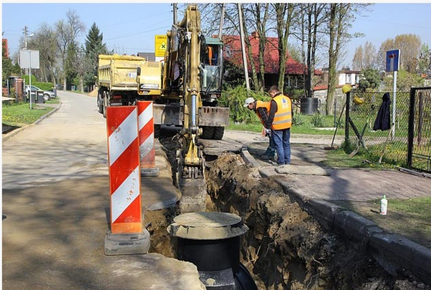
W Sosnowcu - Klimontowie rozpoczęły się prace przy budowie sieci kanalizacyjnej i wodociągowej (fot. UM Sosnowiec)
